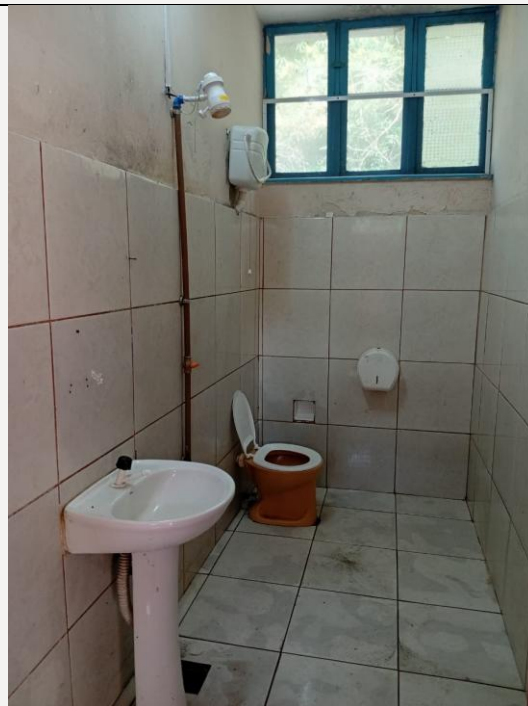
Piso quebrado e tubulação exposta
