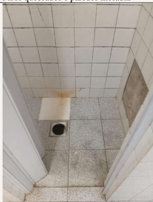
Azulejos quebrados e tampa de ralo faltante
