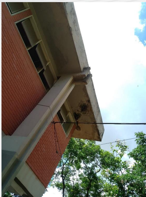
Infiltração teto
