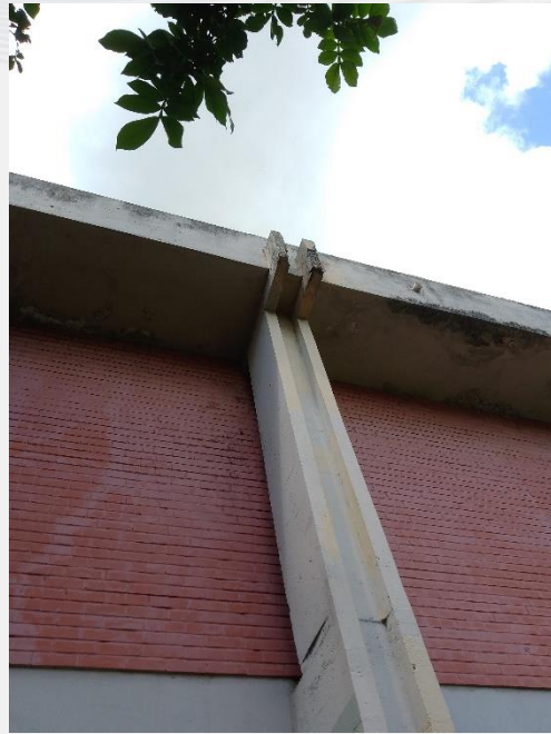
Infiltração (frente)
