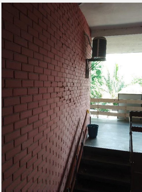
Paredes internas (escada)
