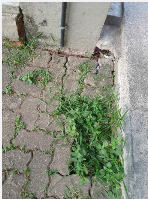
Intertravado esburacado
