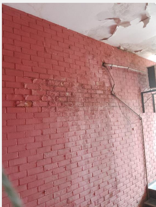
Paredes internas (escada)
