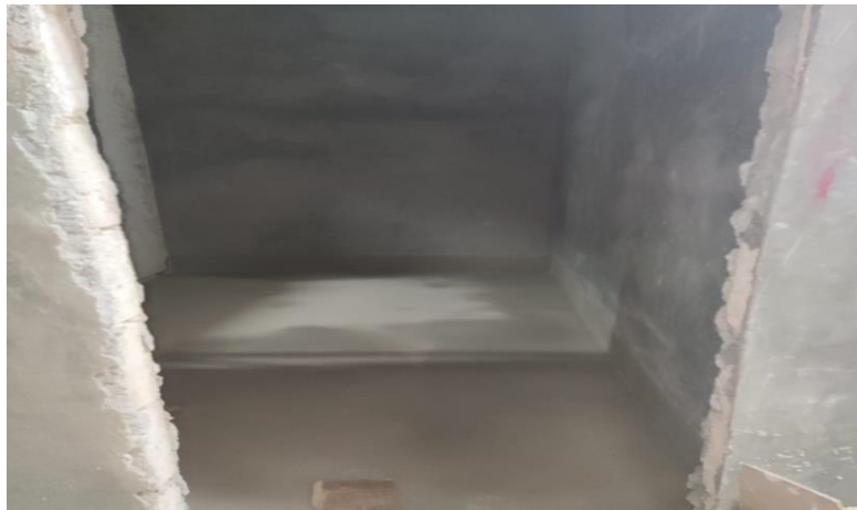
Imagem 4: Sala do comando da ressonância – Térreo
