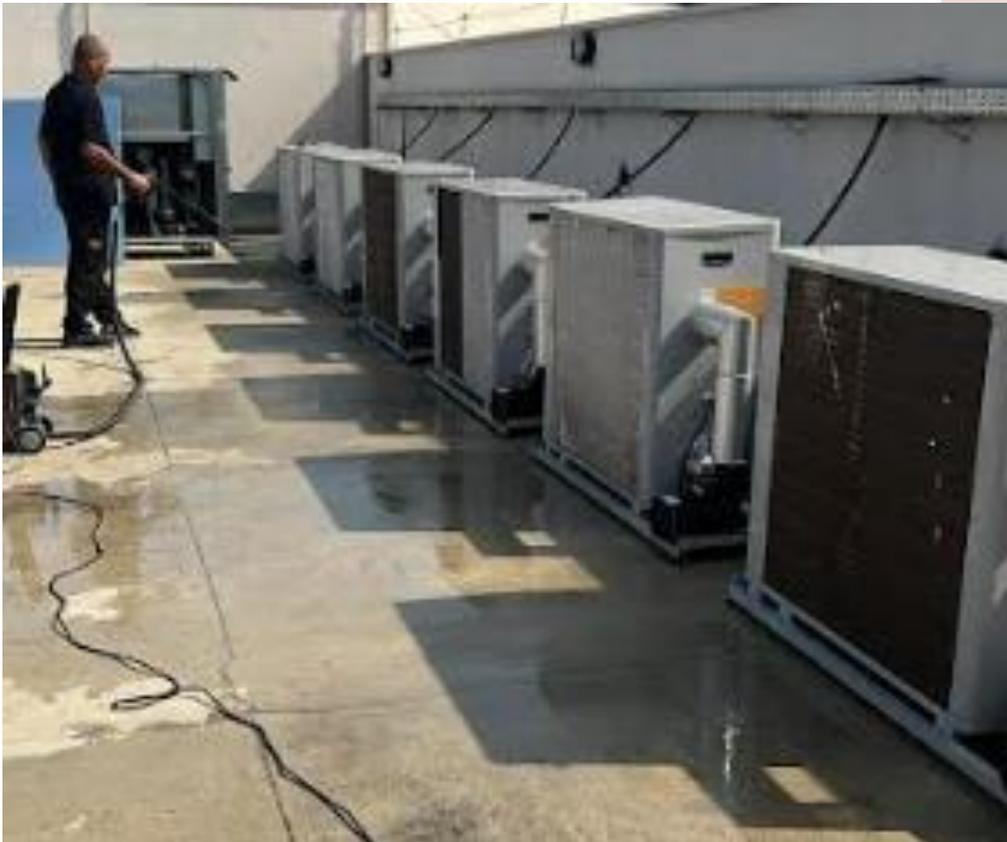
Como medida corretiva, foi realizado resfriamento manual através de mangueira de água e solicitada abertura de processo para instalação de uma cobertura refletora de irradiação solar.
