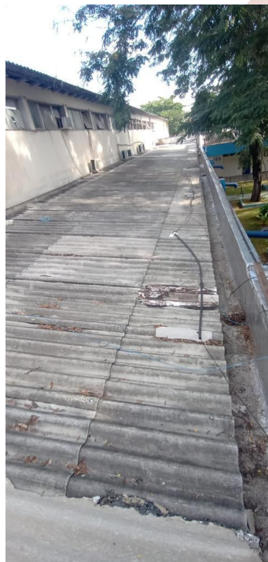
Telhado interno e calha
