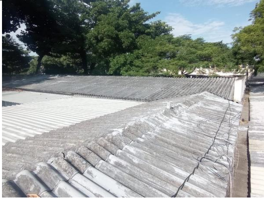
Telhado e cumieira lat. Esq.
