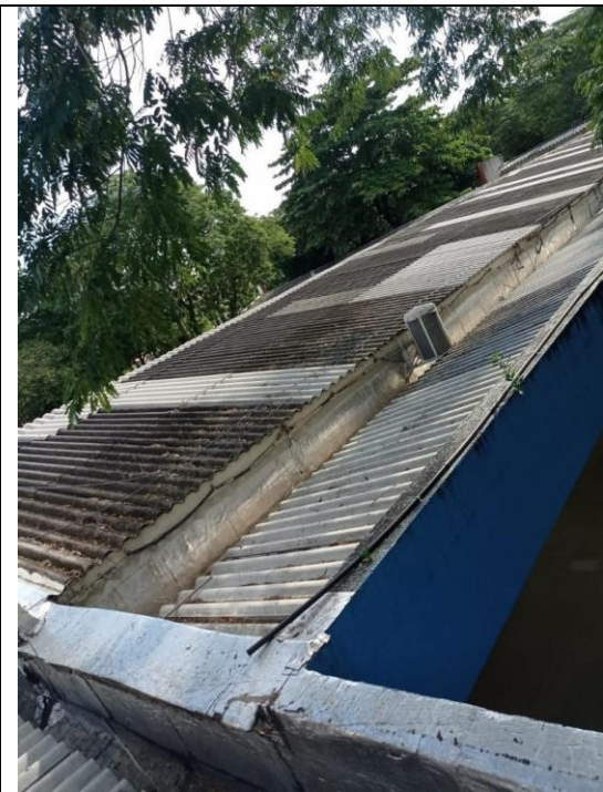
Telhado da lateral esq.
