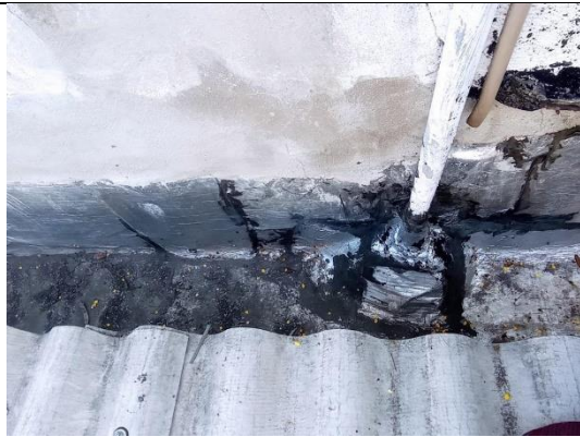
Impermeabilização da calha no fundo
