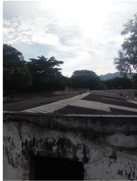
Telhado e cumieira
