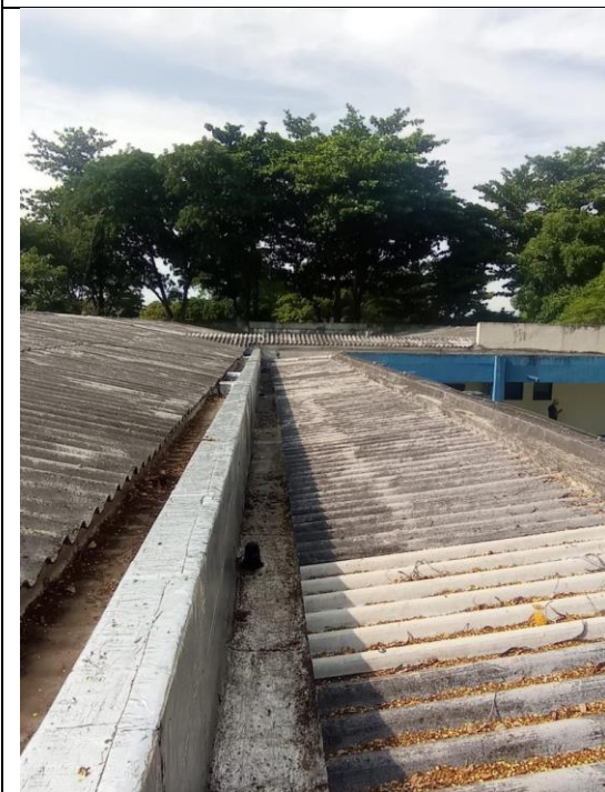
Calha da lat. Dir.
