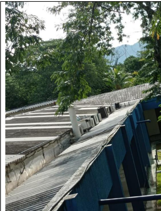
Telhado da lateral dir.
