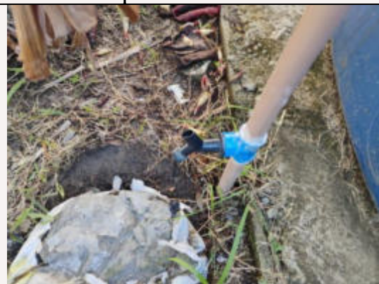
Substituição de torneira
