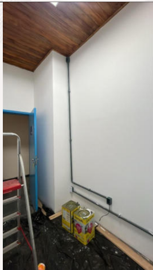
Pintura de parede
