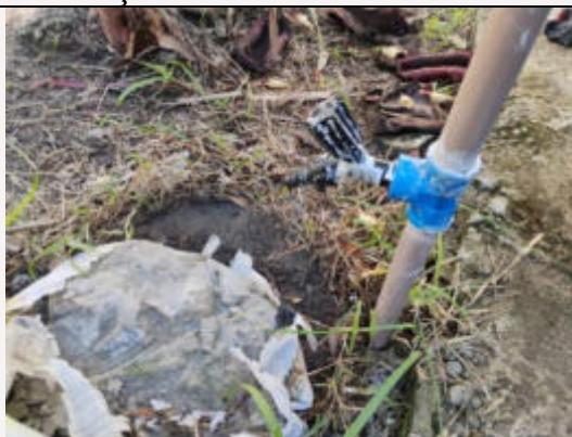
Substituição de torneira
