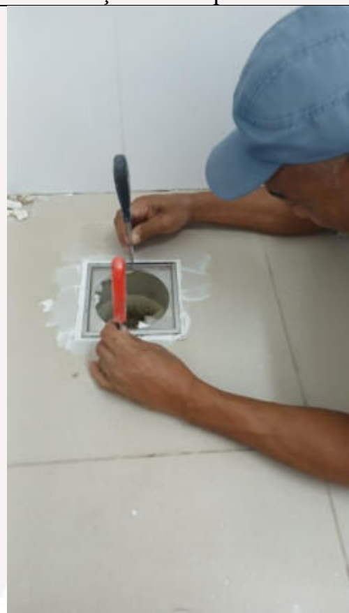
Substituição de tampa de ralo
