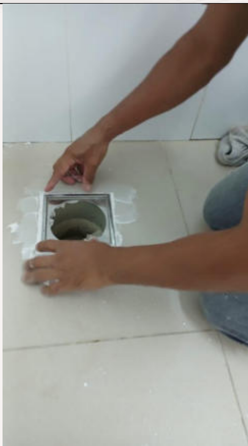
Substituição de tampa de ralo
