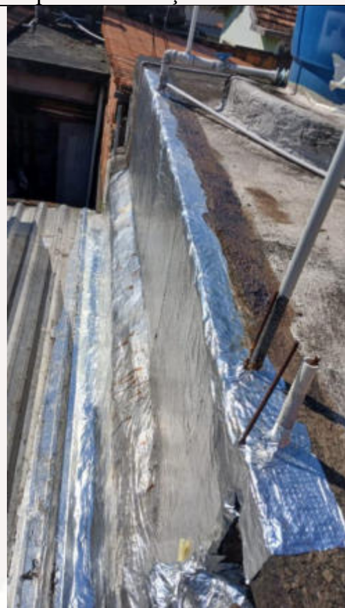
Impermeabilização de telhado
