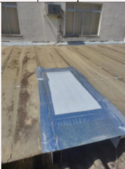
Manutenção de cobertura
