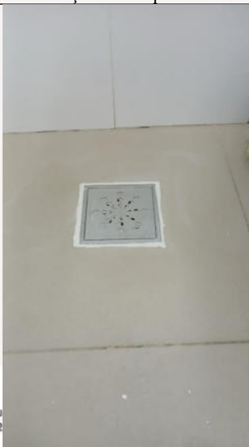
Substituição de tampa de ralo
