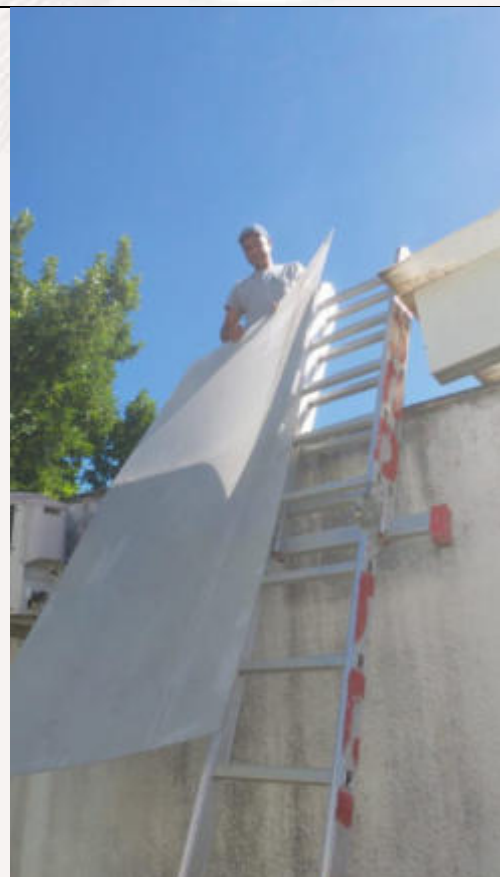
Manutenção de cobertura
