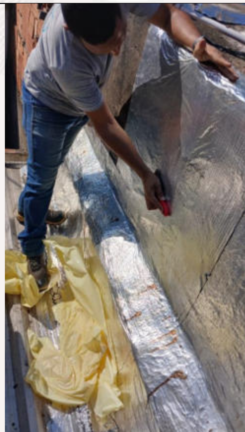
Impermeabilização de telhado
