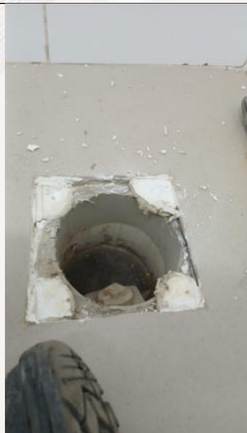
Substituição de tampa de ralo
