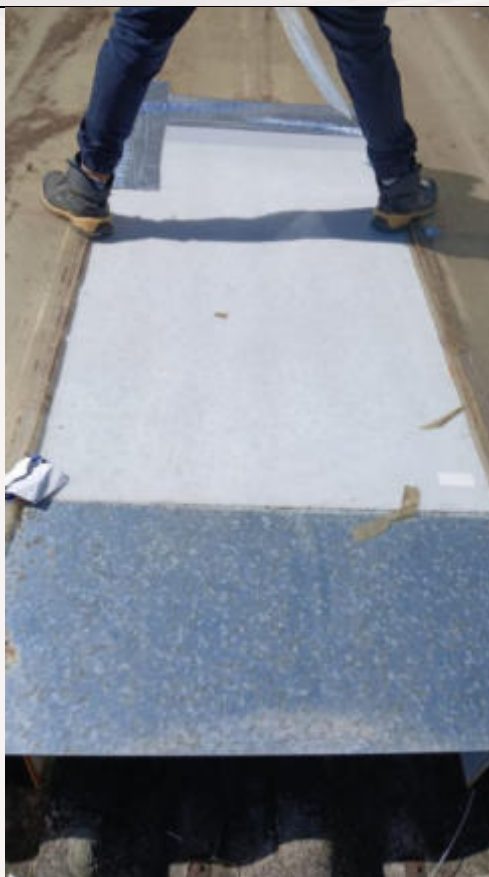
Manutenção de cobertura
