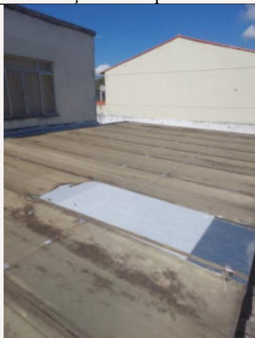
Manutenção de cobertura
