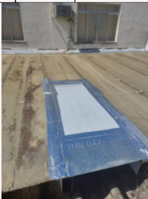
Impermeabilização de telhado
