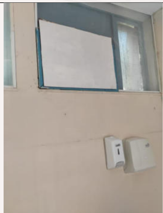
Isolamento de vão de ACJ
