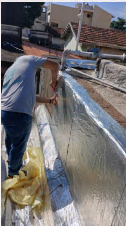
Impermeabilização de telhado
